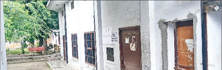
कैथल। पटवारियों की हड़ताल के कारण बंद पड़ा पटवारभवन।
